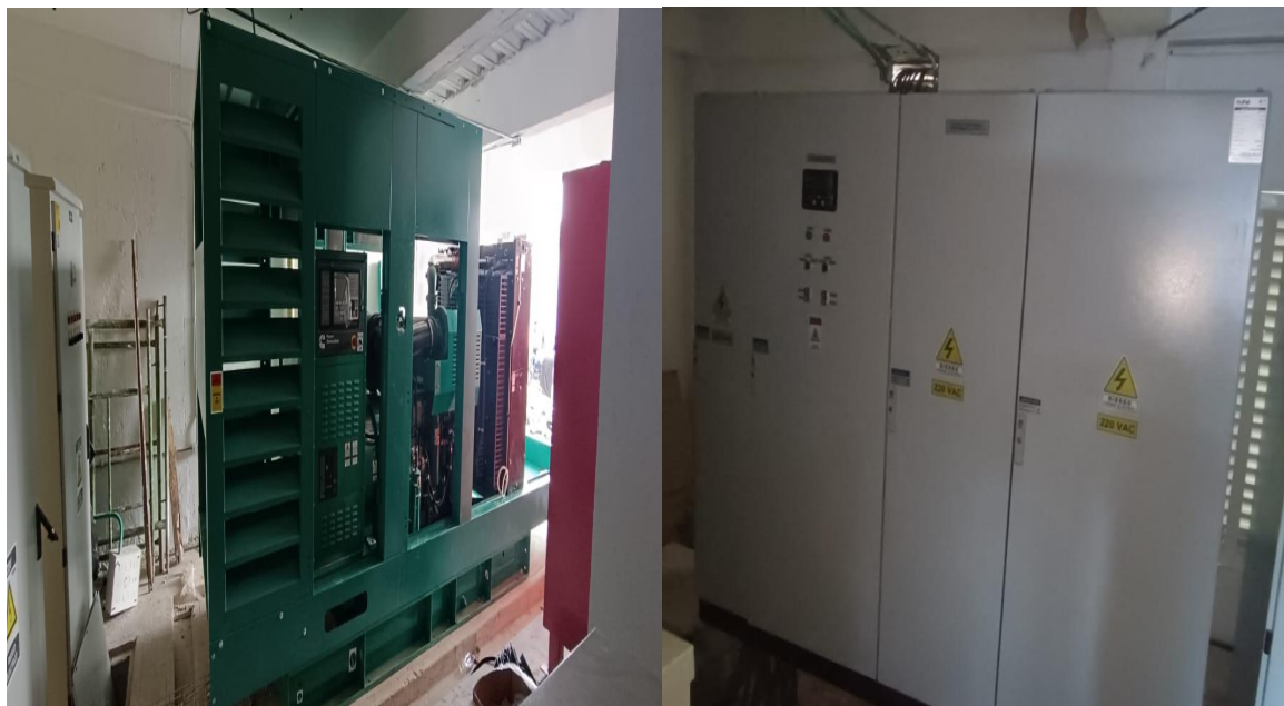
PUESTA EN MARCHA TABLERO DE SINCRONISMO CON TRANSFERENCIA AUTOMATICA (AMPLIACION Y AUMENTO DE POTENCIA SUBESTACION ELECTRICA)
